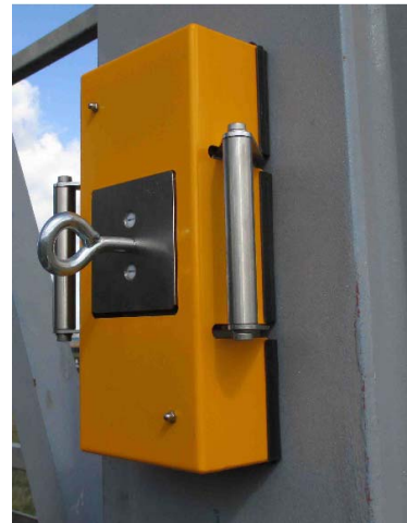
Bild 2: Magnetverankerung mit Schutzhaube und Ösenschraube
